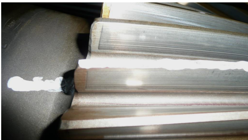
Imagem 2: Área da retirada dos moldes antes do tratamento do aerogerador nº 2
